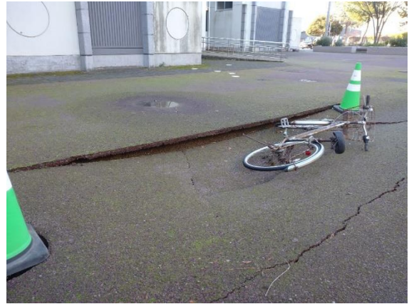
市営住宅敷地内の状況
