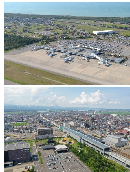
小松空港（上）と 建設が進められる新幹線小松駅（下）
