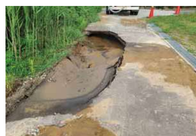
令和6年 圧送管腐食陥没（林町地内）
