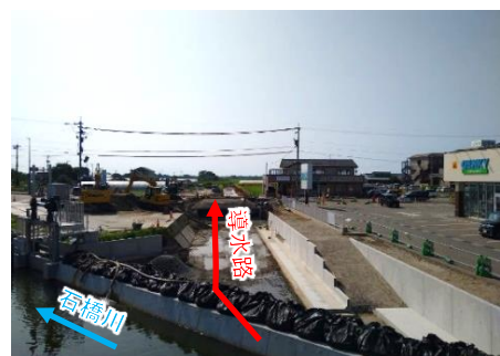
分水施設（越流堰）
