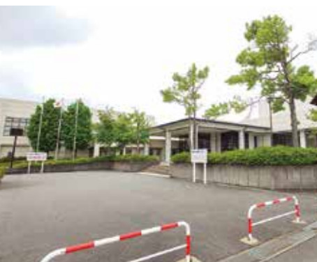
利用者駐車場を拡張する市民センター
