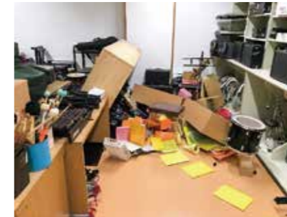
建物内部の状況
