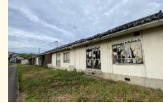
既存市営住宅
