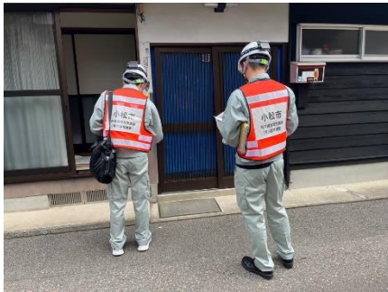
家屋被害認定調査
