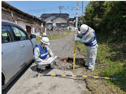
上下水道管路復旧作業
