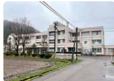
空き校舎など(写真は旧金野小学校)
