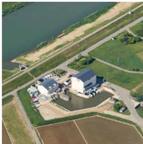
▲ポンプの増設を行う九竜橋川排水機場。排水能力を向上し市街地での浸水被害の軽減を図ります。
