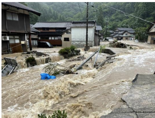
護岸が崩壊した滓上川（中ノ峠町）
