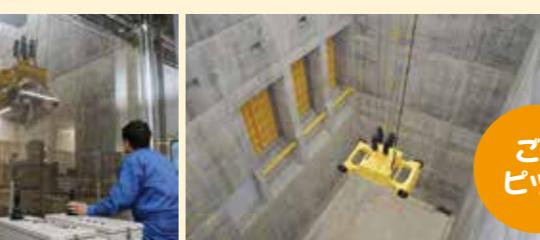
▲ごみピットには580トン(約1週間分)のごみをためることができます。ごみはクレーンで焼却炉入口の投入ホッパに運びます。
