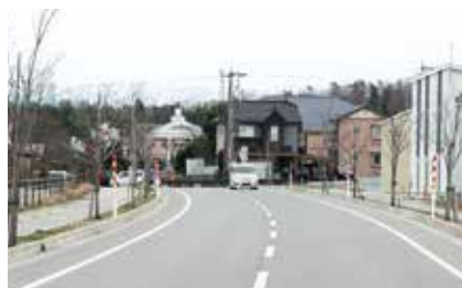
▲国道305号と8号を結ぶ幸八幡線の整備で市内外からのアクセスが更に便利に
