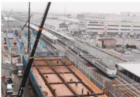
鉄道高架や新駅舎建設の工事が進むJR小松駅付近。列車は仮線を走行（平成12年11月）。
