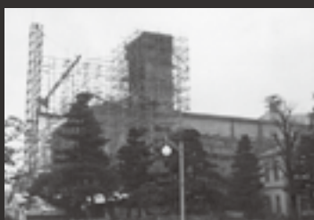
建設中の様子。塔屋が見える
