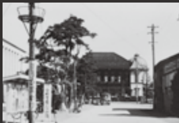
ひきや 建設地にある建物の曳屋工事
