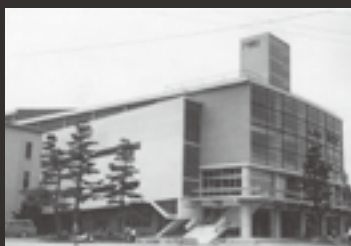
完成当時の公会堂全景
