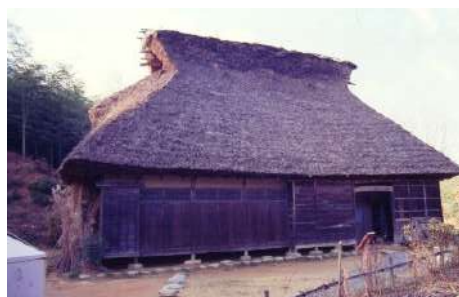
白山麓西谷の民家 (重要有形民俗文化財)
