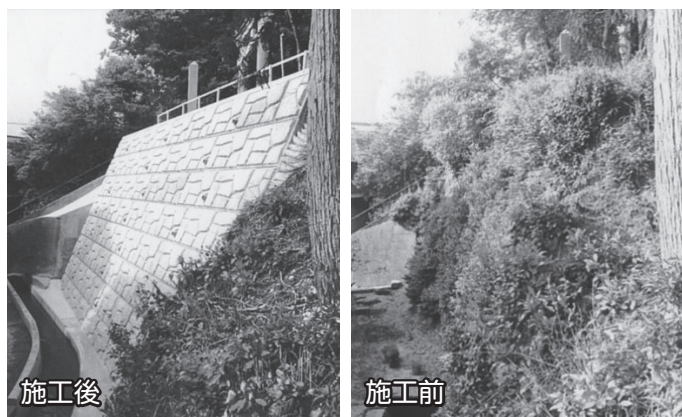
急傾斜地の工事施工前後
