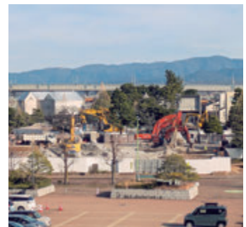
未来型図書館建設予定地
