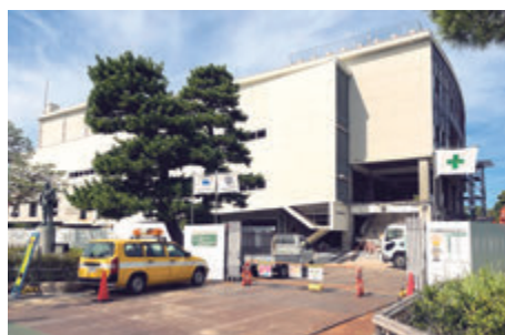
解体中の公会堂
