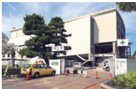
解体中の公会堂
