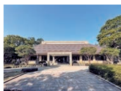
公会堂跡地に新しい図書館が建設される
