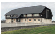
板津地区体育館
