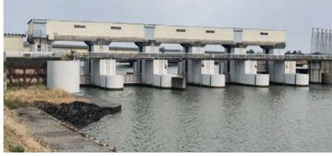
ゲート高不足解消が計画される梯川逆水門
