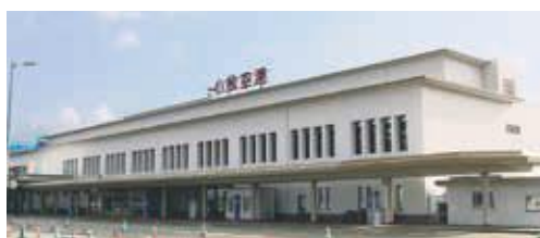
老朽化するエアーミナルビル
