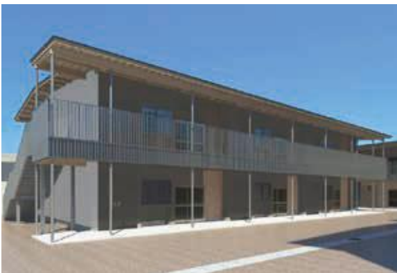
平成31年3月に完成した市営木曾町住宅
