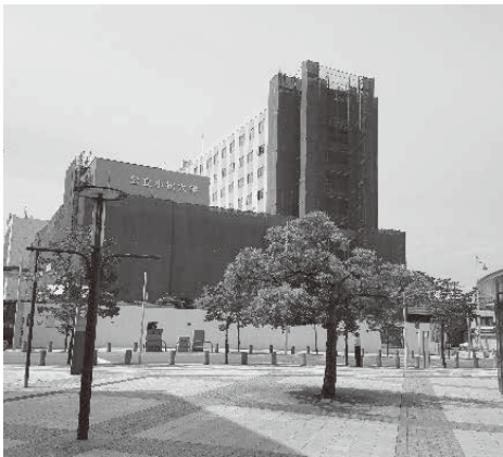
建設中の(仮称)小松駅南ブロック複合施設
