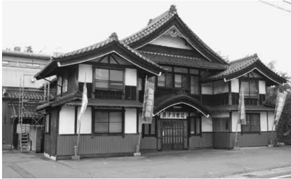
昭和8年に建設された栗津演舞場
