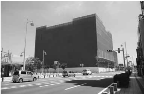
解体が進む旧大和小松店
