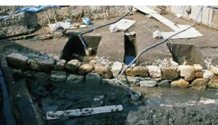
④⑤中土居石垣発掘調査
