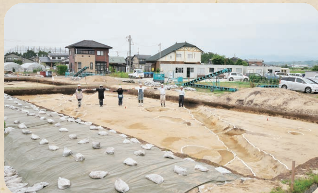
大領遺跡で見つかった幅約8mの古代の道路遺構。北東方向へ延長させると加賀国府や国分寺推定地周辺に至る (石川県埋蔵文化財センター提供)
