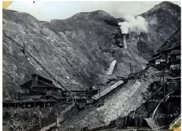
昭和10年頃(c.1935)の尾小屋鉦山製錬所と煙突
