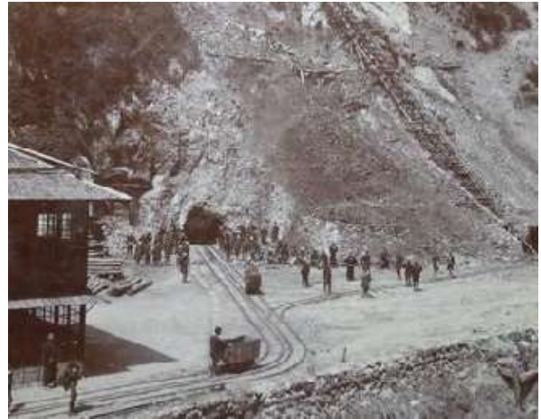
横山家経営期の尾小屋鉦山(本舗坑口)
