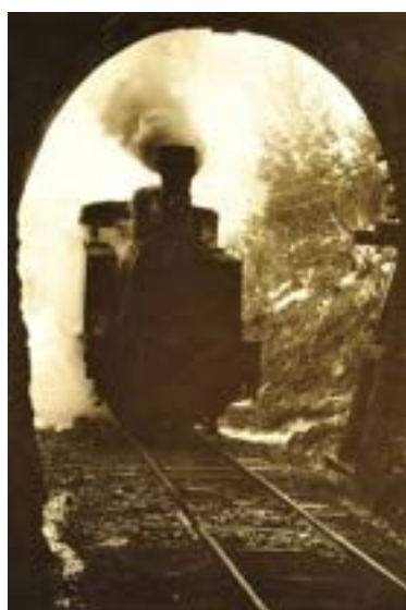
倉谷隧道へ入る5号蒸気機
