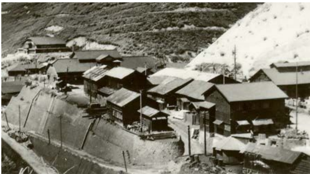
馬車道の風景（カラミ煉瓦を積み上げた擁壁の上奥に鉱山事務所の後ろ姿がみえる）
