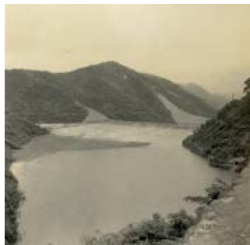
かつての沈殿池
