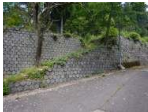
六角形のカラミ煉瓦を積み上げた擁壁
