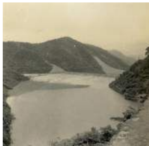
かつての沈殿池
