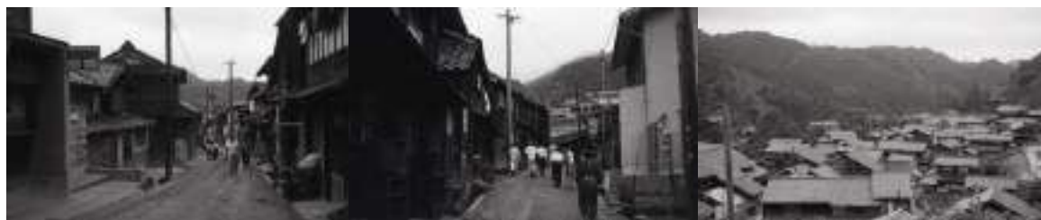
多くの建物が建ち並ぶ鉱山まちの様子 昭和 37（1962）年 6 月
