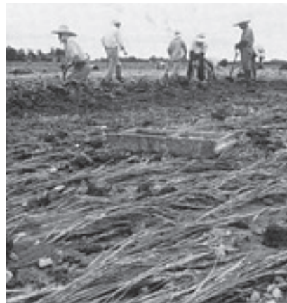
昭和43年(1968)8月29日、台風10号によって梯川がはらんし、水田に石などが流れ込んだ(千代町、『小松市制50周年記念誌』より) 鍋谷川や八丁川の堤防も決壊した。
