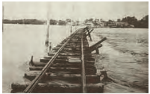
昭和9年(1934)7月12日、手取川の氾濫によって、能美線の線路を越えて板津村へ流れる濁流
