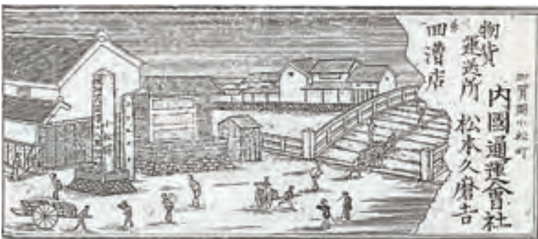
小松町九竜橋詰(小松市立図書館所蔵) この橋の付近は、北陸本線の開通まで宿駅小松の中心として栄えた。左側に高札を掲げた高札場、その手前に里程元標がある。(明治前・中期)
