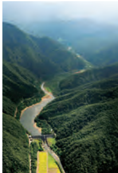
洪水調整を主目的とする重力コンクリートダムの赤瀬ダム（平成22年9月撮影） まだ一度も使用されていない放水用の施設（非常用洪水吐きクレストゲート）も備える。
