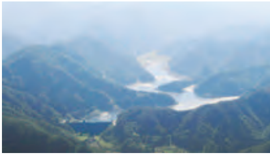
大日川ダム 阿手堰防より旧小原地区(旧新丸村)を望む景観(平成19年撮影) 左手前に重力式コンクリートダムがみえる。
