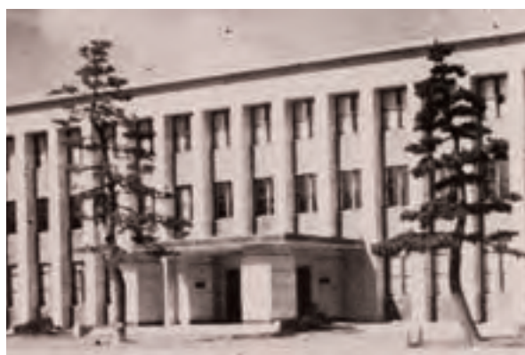
小松市役所(昭和27年) (小松市立博物館提供) 耐震耐火鉄筋コンクリート地下1階・地上3階、敷地3960 m 2 ・建坪1721 m 2 ・延坪5092 m 2 、総工費7680万円
