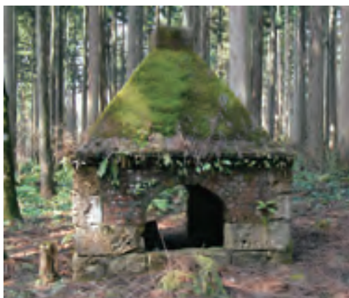
遊泉寺銅山跡地に残る真吹炉(コマツ栗津工場70周年記念誌「MADE IN AWAZU」より)
