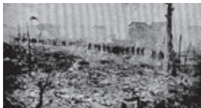
焼け残ったのは土蔵のみ。鎮火後、嬉しさのあまり蔵の扉を開け、二次災害を受けた例もある(昭和5年3月29日付北國新聞)
