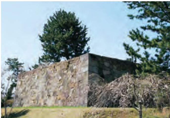
本丸櫓台北東隅角部現況
