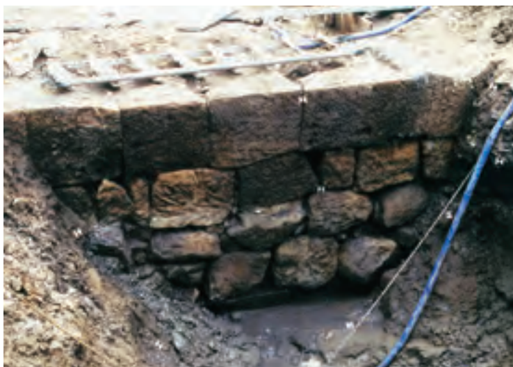
小松城二ノ丸の石垣(小松高校旧第一体育館西側。平成11年撮影)
