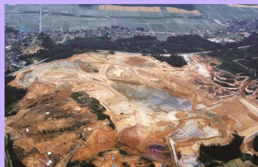
造成工事と調査が並行する河田山古墳群
