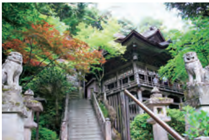
白山加賀馬場の中宮勢力の伝統を継承する「那谷寺」大悲閣拝殿
