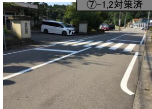
⑦校門前道路(主要地方道丸山加賀線)
