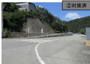
②観音下町 小学校付近横断歩道
