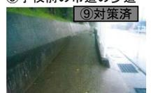
大雨、積雪、落葉時に歩道に水がたまる。廃水の孔が小さく、設置位置が高い。歩道の傾斜の山側が高くなっている。
