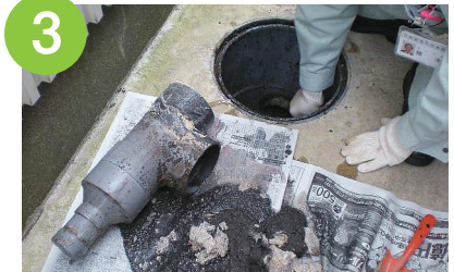
3 水分がとれた油かすなどは、生ゴミと一緒に処分してください。
