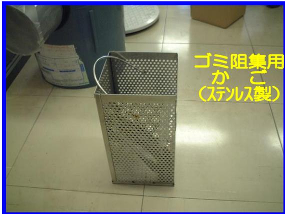
●かご（阻集器）は、下水道処理の妨げとなる物質（し査など）の流入を阻止、分離、収集し、下水処理場における放流水の水質を確保するため、各家庭の特に台所、浴室、洗濯場等の排水箇所に設ける機器です。処理場に流入するし査の量を減少させる効果があります。
