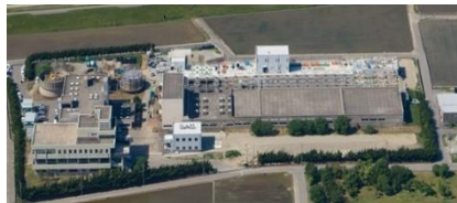
中央浄化センター
