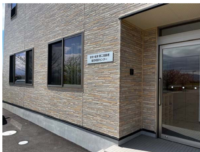
安宅・板津第二高齢者総合相談センター(外観) (特別養護老人ホーム 明峰の里の正面向かって左側にあります)
